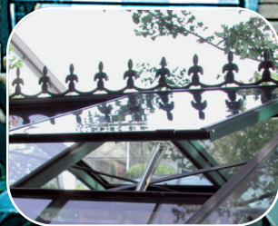
Dachfenster mit automatischen Fensteröffnern
